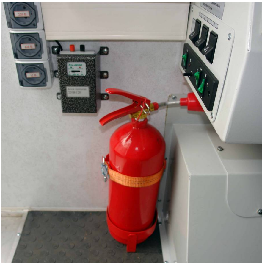
Рис. 34 Размещение огнетушителя
